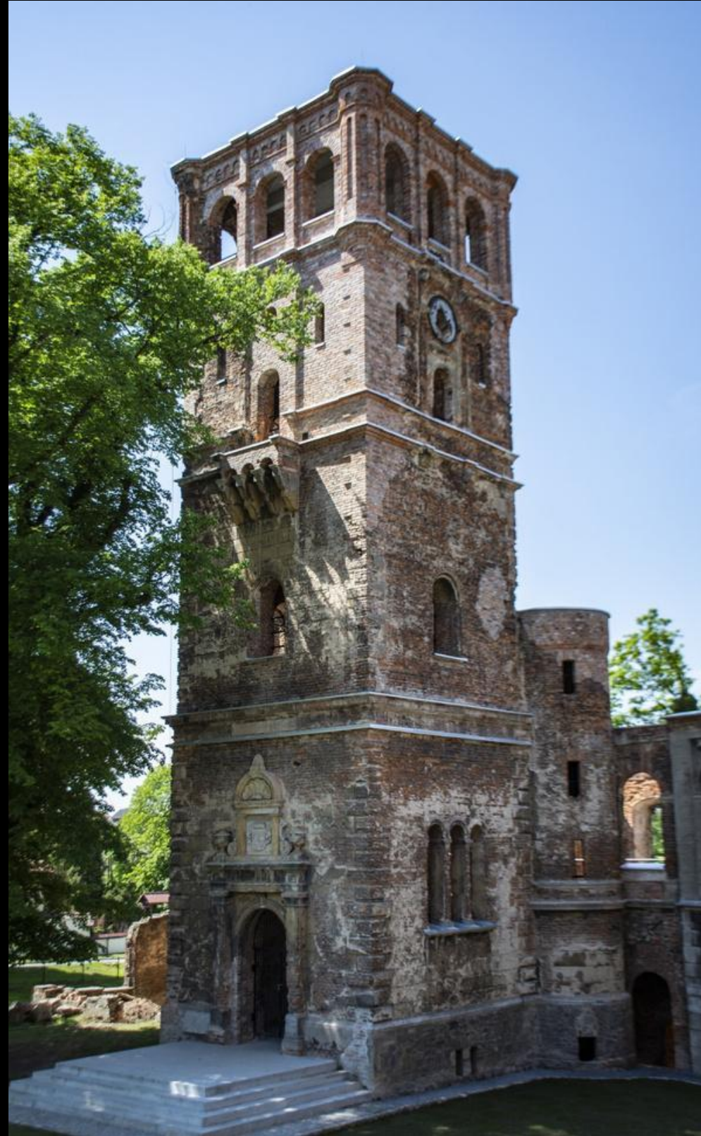
Uzupełnienie istniejącej tkanki, rewitalizacja ruin Zamku w Tworkowie, Witeczek Jerzy Pracownia Architektoniczna Gliwice
