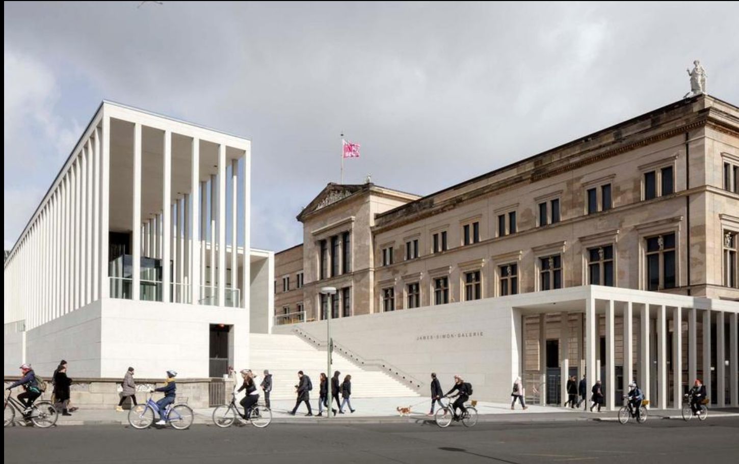
Wprowadzenie nowej kubatury, James Simon Galerie, David Chipperfield Architects, Berlin 2018
